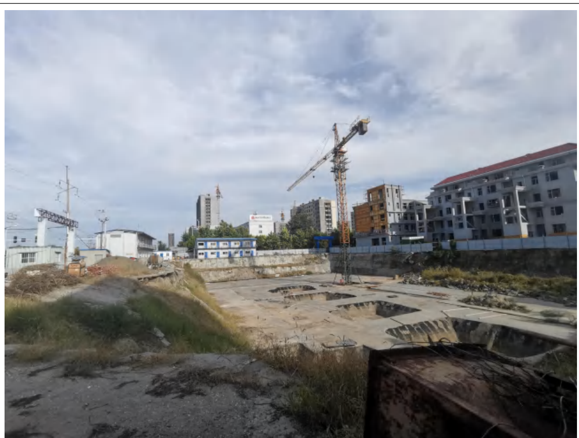
本地块内：南侧已开挖，建设地下防水设施；北侧及东侧彩钢板房为施工临时宿舍及办公区。
